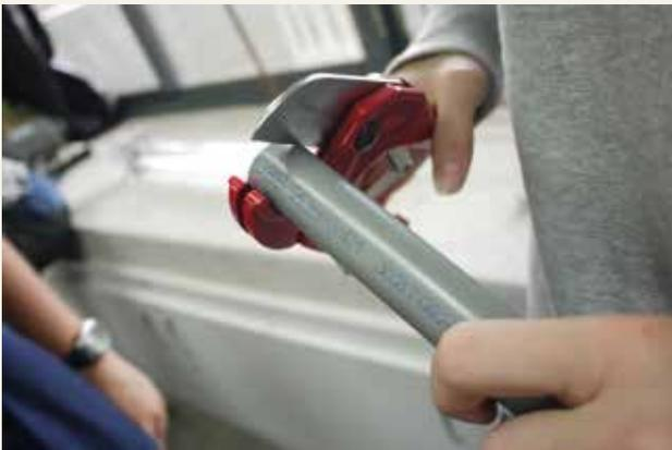
圖 6-2 3/4" PVC 水管，可用剪水管專用剪刀直接裁切
